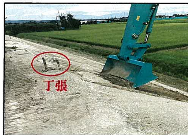
丁張を目安に施工
