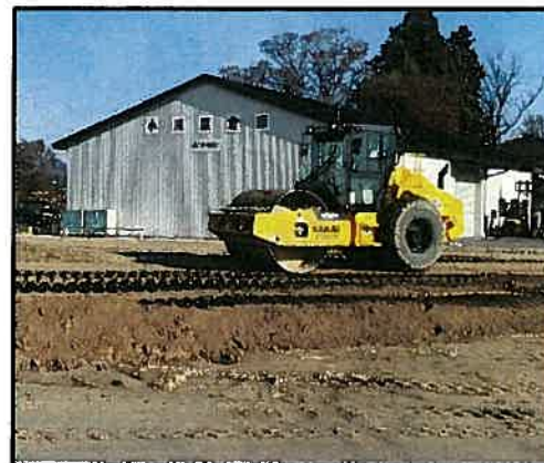
モニターに表示されている回数で転圧施工
